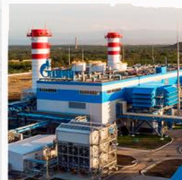
ТЭС на газе 490 г (CO 2 )/КВт в час
